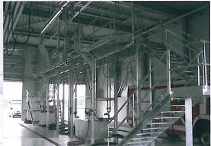
Stacja czyszczenia wewnątrz dla zbiorników, silosów i kontenerów w jednym z centrów Cargo.
