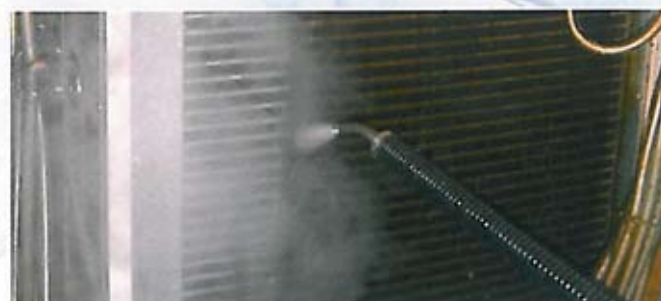
Czyszczenie wymienników ciepła.
